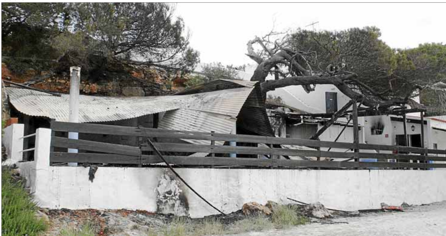
Las llamas destrozaron en la madrugada del martes la terraza del conocido restaurante Sol.
