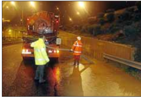
Trabajos de achique del agua para abrir el carril.
