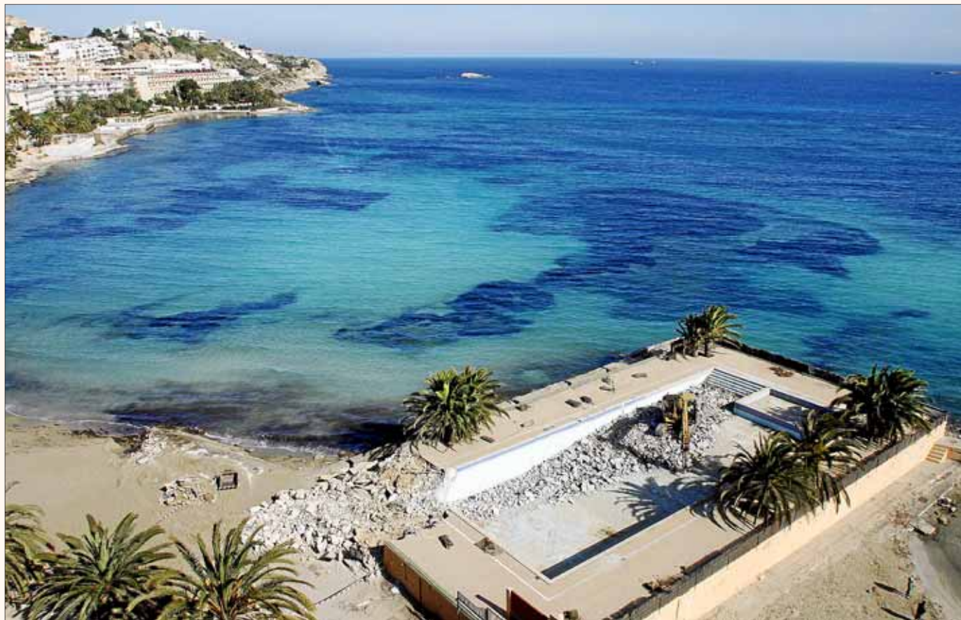
Vista aérea de los trabajos de eliminación de la piscina. Foto: MARCO TORRES
