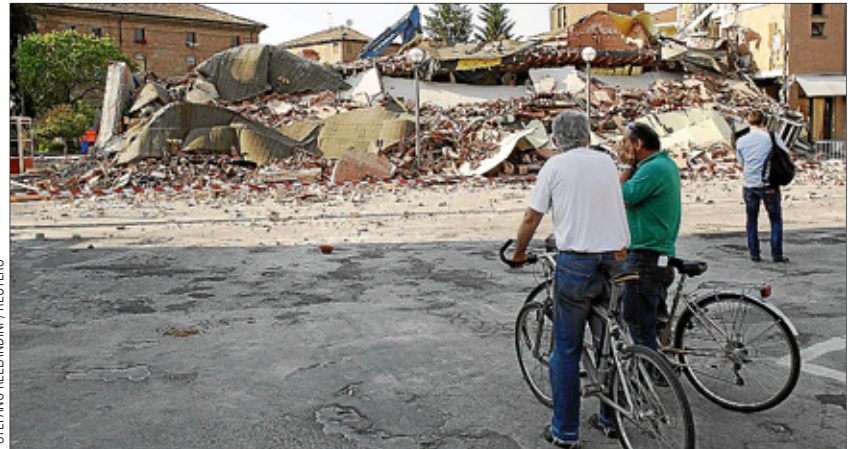
El terremoto convirtió casas enteras en un montón de escombros.
