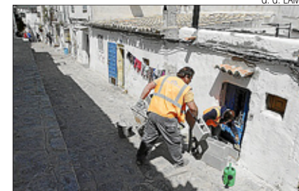
Dos operarios tapan el acceso a una de las infraviviendas que desaparecerán.
