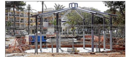
Los trabajos realizados hasta ayer.
