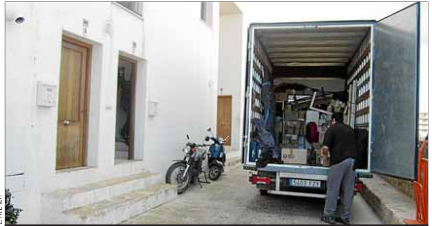
Imagen de las VPO de Dalt Vila que tienen que ser abandonadas.
