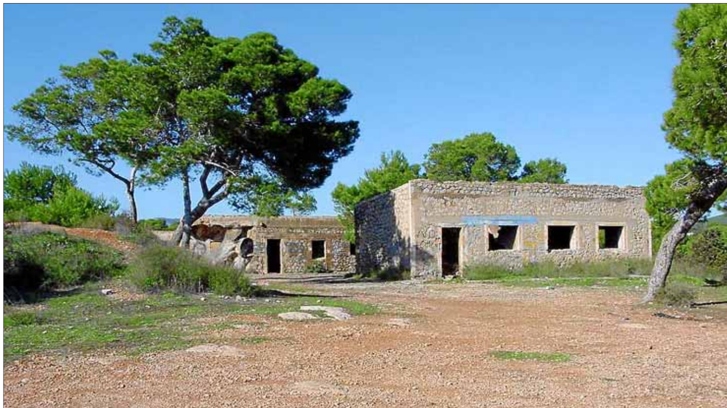
El centro de interpretación se instalará en este edificio, construido en los años cuarenta y abandonado veinte años después.
