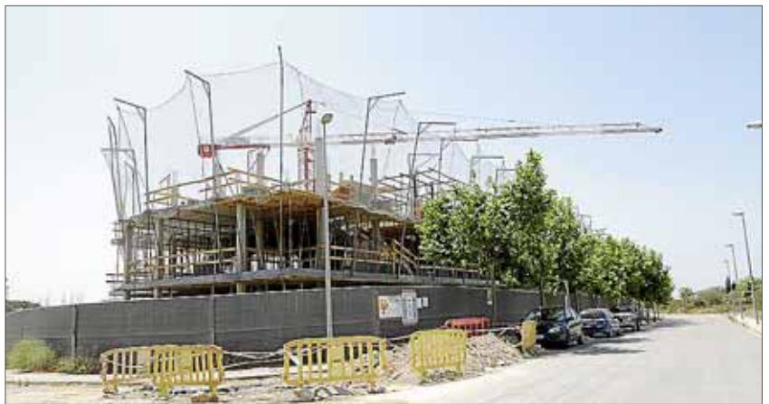
Varias fincas de esta zona de Jesús han iniciado las obras.
