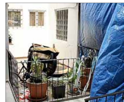
Patio interior de la finca siniestrada.
