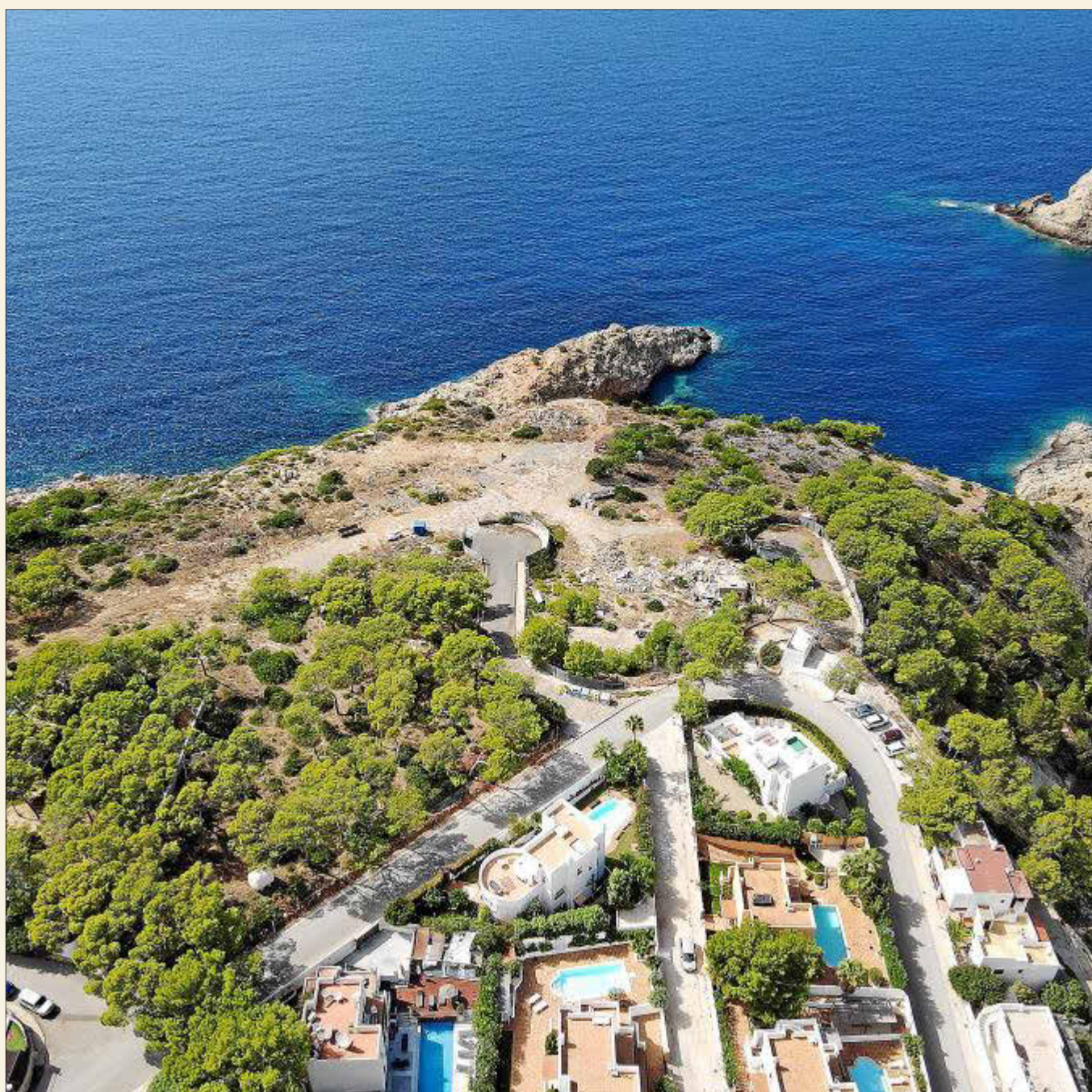
Imagen aérea del solar de Cala Vedella en el que Sant Josep permitirá 12 villas de lujo gracias a una licencia de 2005.
