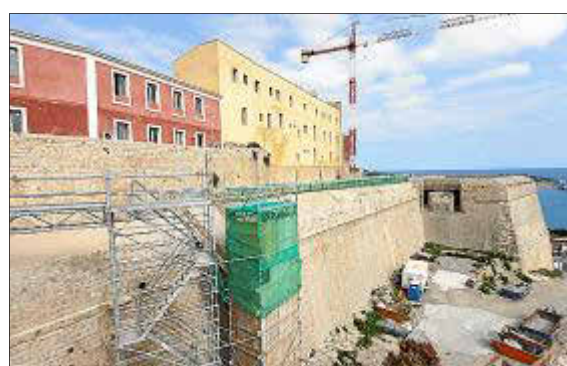
Las obras paralizadas ayer. Foto: DANIEL ESPINOSA
