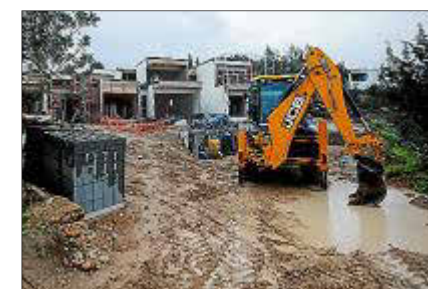
Imagen de las obras de Can Germà.
