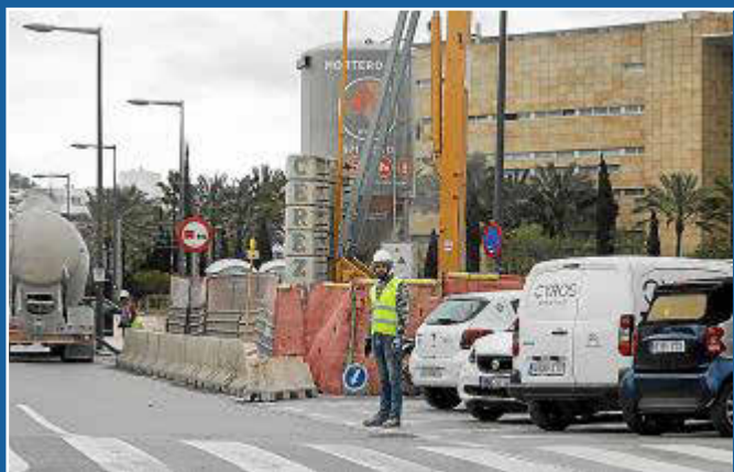
Paseo Juan Carlos I. Una de las arterias de la ciudad, con obras.
