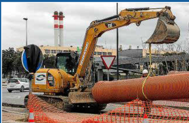
Avenida Ignasi Wallis. Las obras del colector llevan más de un mes.
