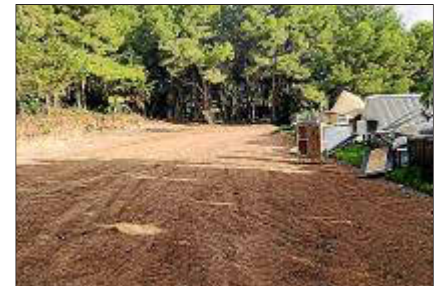
Imagen actual de Casa Lola tras los trabajos.
