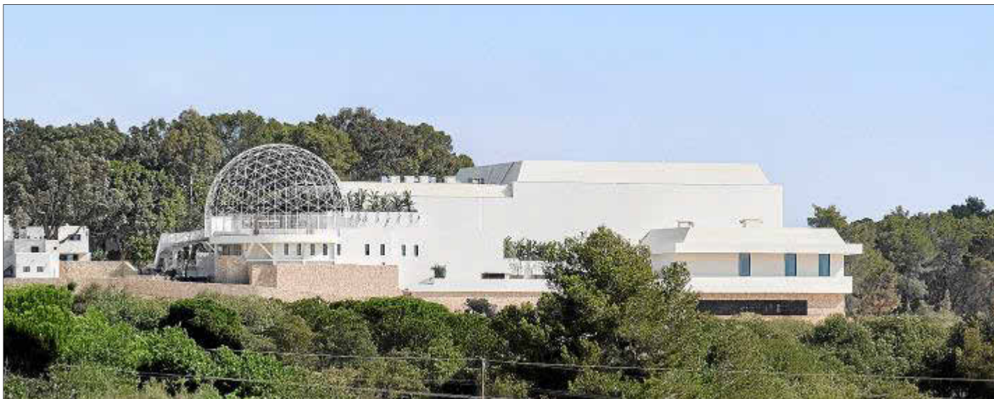
Las obras avanzan a buen ritmo y se mantiene la cúpula tan característica. Foto: [UNVRS]
