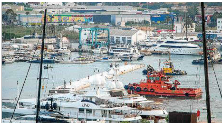
La plataforma de hormigón mide 145 metros de eslora y ocho metros de manga. Foto: JÉSICA LÓPEZ
