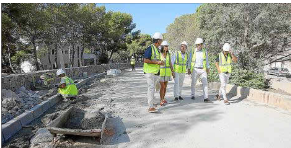
El conseller Bauzà recorrió las obras de varios puntos con Triguero. Foto: MOISÉS COPA
