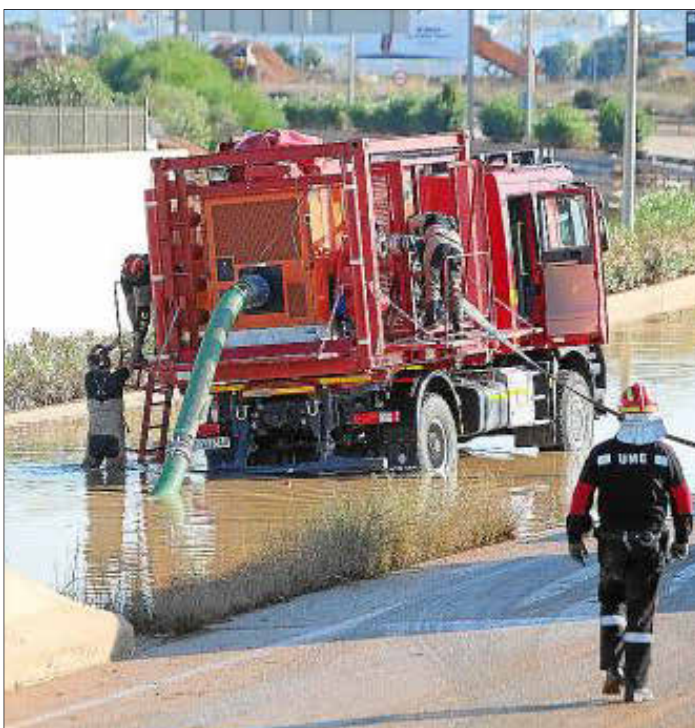
Vista la magnitud de la tragedia, se solicitaron tres bombas capaces de bombear 15.000 litros por minuto. Foto: MOISÉS COPA
