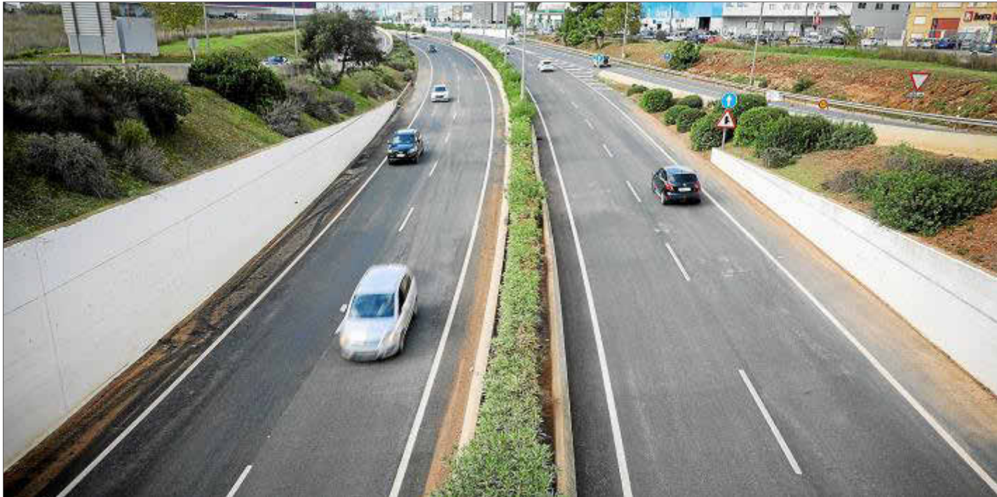
La UME tuvo que drenar cuatro millones de litros de agua de la carretera del aeropuerto, que este martes a primera hora reabrió al tráfico. Foto: TONI P.
