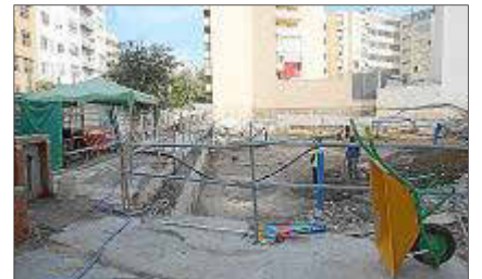
Se inundó el solar y ya se ha vaciado. Foto: M.C.
