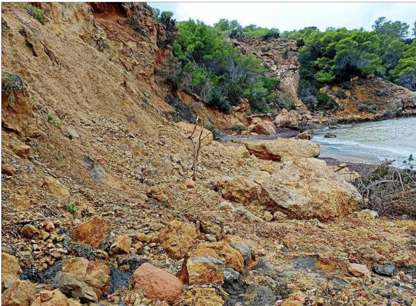
Se ha cerrado la parte izquierda de la playa y se está trabajando en restablecer la normalidad. Foto: AYTO SANT JOAN
