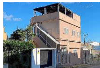
El edificio situado en la calle Joan Xicó.
