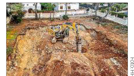
Una excavadora trabajando en el solar. Foto: HP
