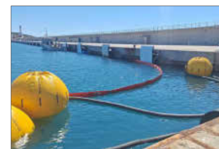
Trabajos de balizamiento en es Botafoch.
