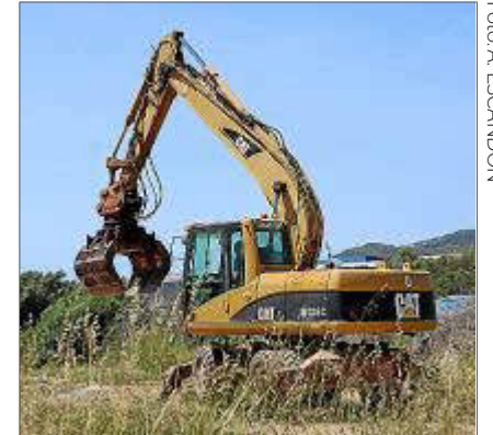
Las máquinas entraron para dismantlar las decenas de chabolas que había en el solar.
