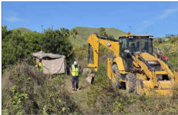
La excavadora entró para proceder a destruir las chabolas. Foto: G. REVELLES
